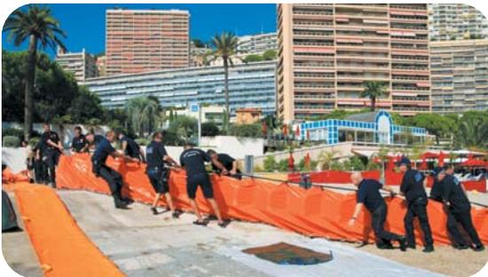
Déploiement du barrage flottant antipollution
